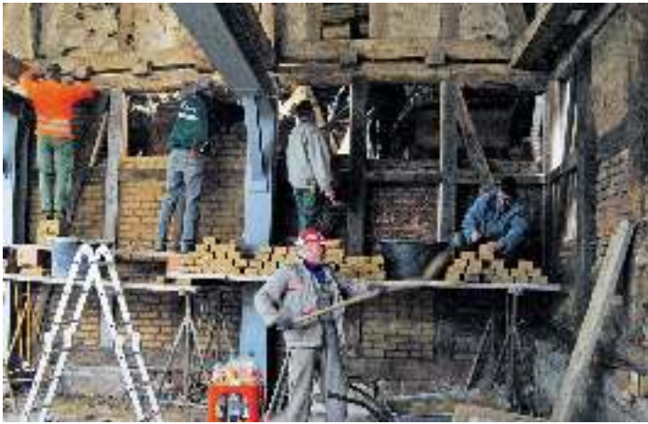
Mit viel Eigeninitiative hat sich in Schróck ein Förderverein dafür eingesetzt, eine alte Scheune zum Kulturzentrum umzunutzen und selbst zu betreiben.
