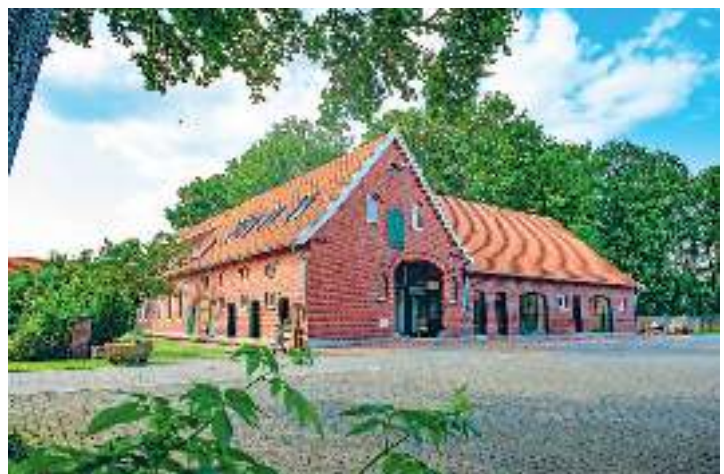
Der Umbau zum Coworking-Space auf dem Gehöft wurde Ende November fertig. Die ersten Arbeitsplätze in „calle3“ konnten vermietet werden.
